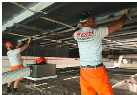
Applikation der S&P CFK-Lamellen
