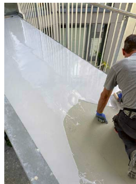
Kalt appliziert, schmiegt sich das Spezialharz an alle Gegebenheiten nahtlos an und bezieht auch die Details sicher in die Abdichtung ein.
